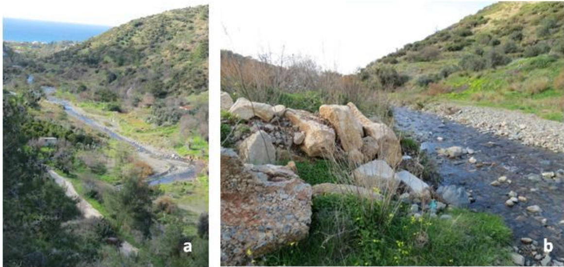
Σχήμα 19. (a) Άποψη της ελαφρώς διακλαδιζόμενης περιοχής του ποταμού κατάντη του φράγματος (b) Μπάζα από κτίσματα και οικοδομές μέσα στην κοίτη. Διακρίνεται η απουσία υγρόφιλων δένδρων και θάμνων στην όχθη (Φώτο: Σ. Ζόγκαρης, Φεβρουάριος 2013)
