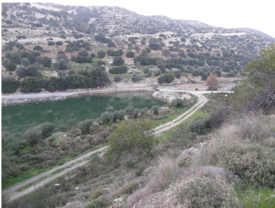
Σχήμα 27: Άποψη του ασφαλτοστρωμένου δρόμου που διασχίζει τον ποταμό και ο οποίος προτείνεται να απομακρυνθεί προκειμένου να επιτευχθεί η απρόσκοπτη ροή του νερού προς το φράγμα και η αποκατάσταση της υδρομορφολογίας του ποταμού (Φώτο: Ι. Τζιωρτζιής, Φεβρουάριος 2013).
